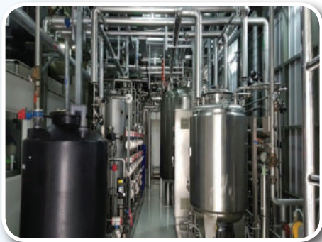
ระบบผลิตน้ำบริสุทธิ์ น้ำกลั่น และไอน้ำบริสุทธิ์ ยี่ห้อ Stilmas จากประเทศจีนสำหรับใช้ในกระบวนการผลิตเซรัมและยาปราศจากเชื้อ
