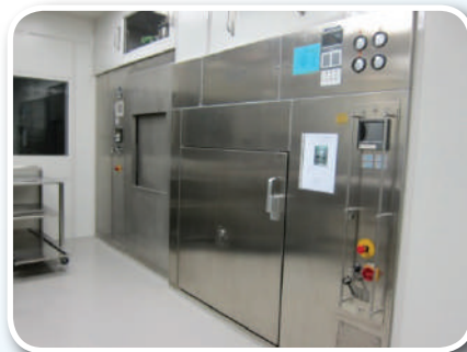
เครื่องฆ่าเชื้อด้วยไอน้ำความดันสูงและเครื่องฆ่าเชื้อด้วยความร้อนแห้ง (Autoclave and Hot air oven)
